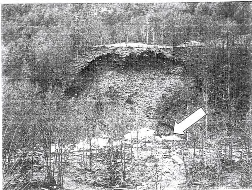
Figura 2-1 – Erosione della scarpata di sponda destra. La freccia indica la scogliera realizzata a seguito delle opere precedentemente compiute (foto 1119-P4240143.JPG).
