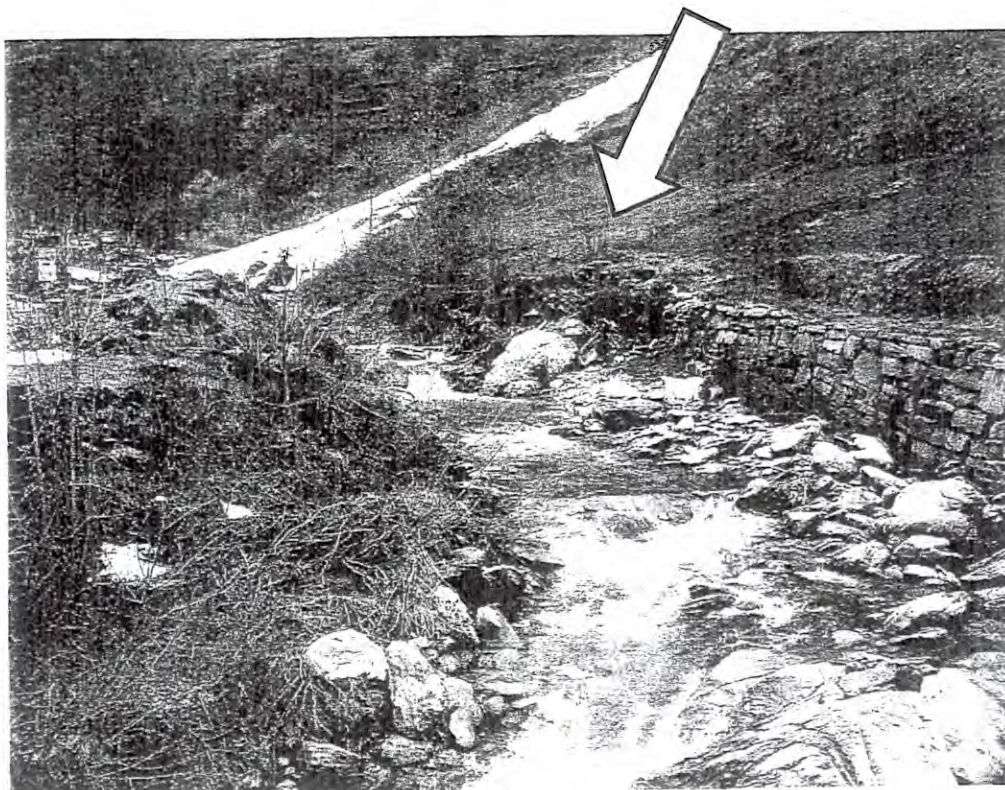
Figura 2-2 - La freccia indica l'accumulo del materiale determinato dalla valanga in sponda sinistra a monte della scogliera di protezione al piazzale (foto P4240114.jpg).
